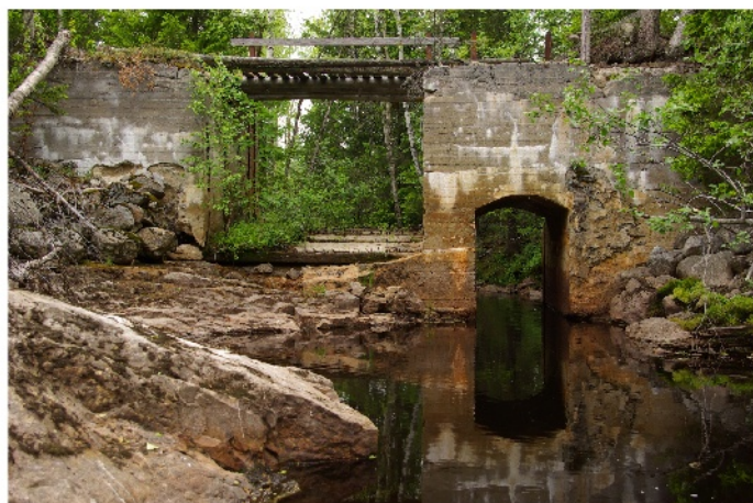
Dammen nedströms sänkta Fällforssjön.
