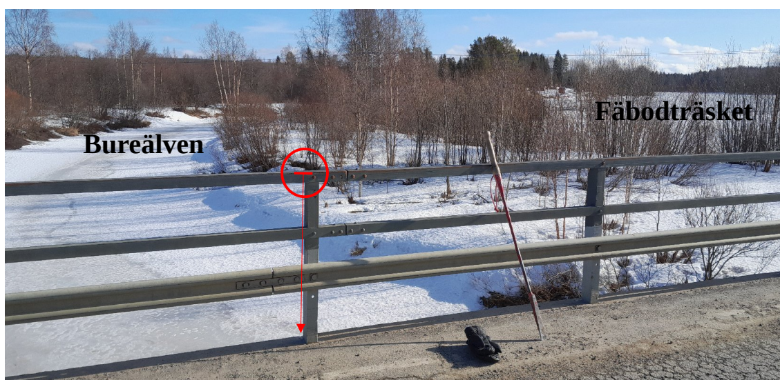
Figur 8: Ny mätpunkt för vattenstånd. Mätningen gjordes från räckets överkant till älvens vattenyta. Avståndet var 6,10 m denna dag. Foto: Leif Vestermark 2025-03-13
