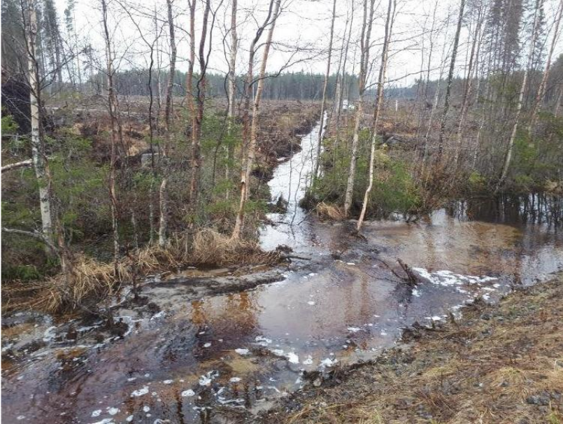
Sediment har fyllt vägdiket 10/5 2021.
