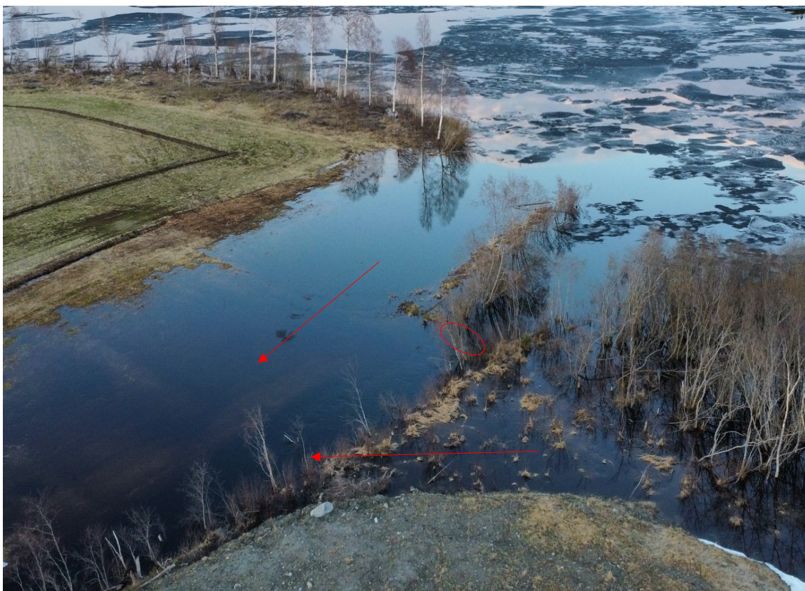
Figur 28: Högfjärdens högsta nivå kan vid höga flöden snudda åkermark som ligger omkring 590 cm över referensytan (RH2000). Notera att 1989 års tröskel (inringad) inte avgör vattenståndet vid denna typ av höga flöden. Foto: Jan Åberg den 16 maj 2024. Vattenståndet var ca 579 cm.
