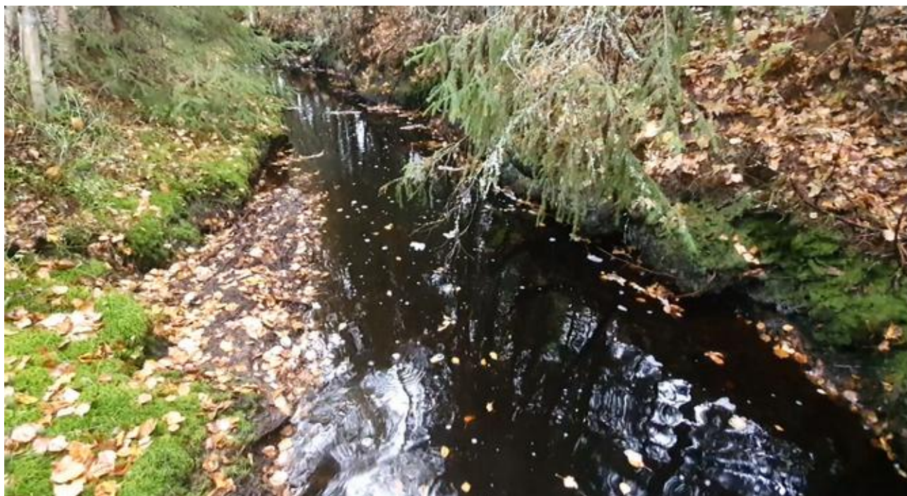
Vy nedströms med rensningsvallen på högra sidan.
