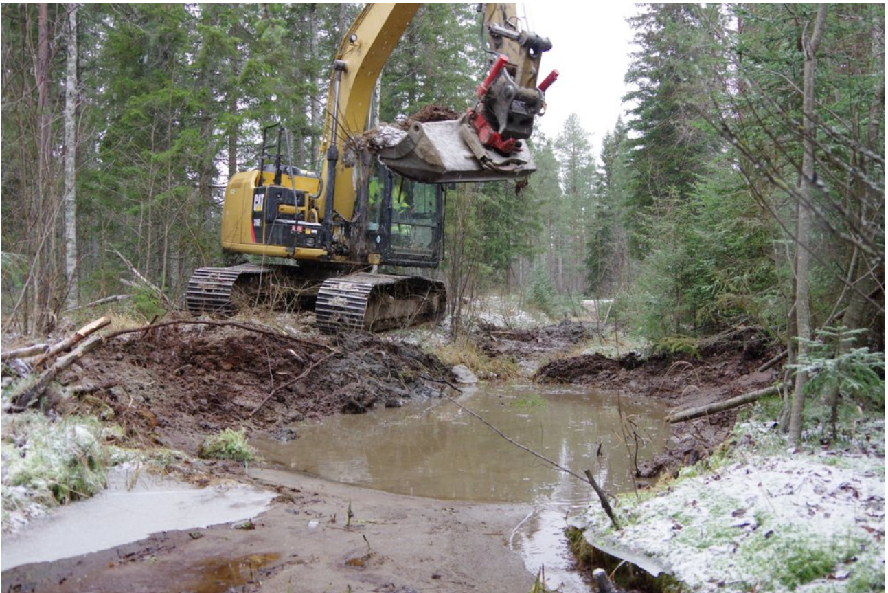
Figur 15: Byggsfas för nedre djuphålan och tröskeln.
