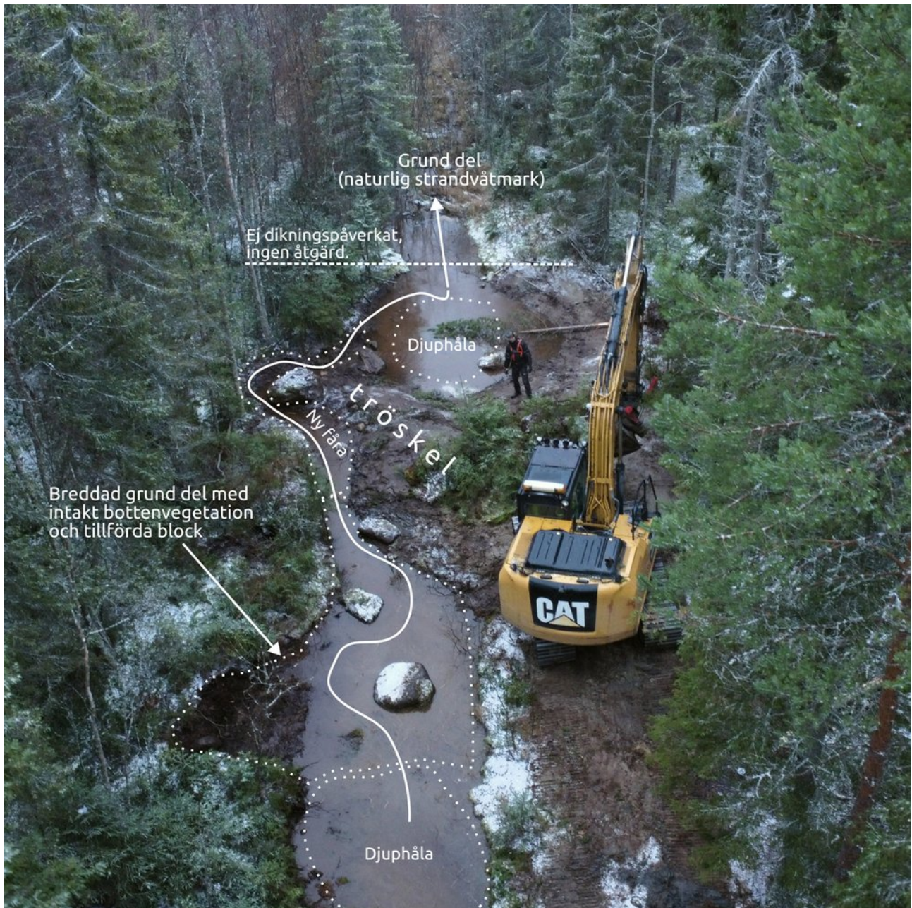
Figur 14. De två sedimentfällorna i Porsviksdikets nedersta sträcka, nedströms föreningsvägen, utformades för att få varsin djup del och varsin grund del. Det övre grunda området har skapats genom att bredda diket, medan den nedre grunda delen utgörs av den naturliga våtmark som redan fanns innan åtgärd.
