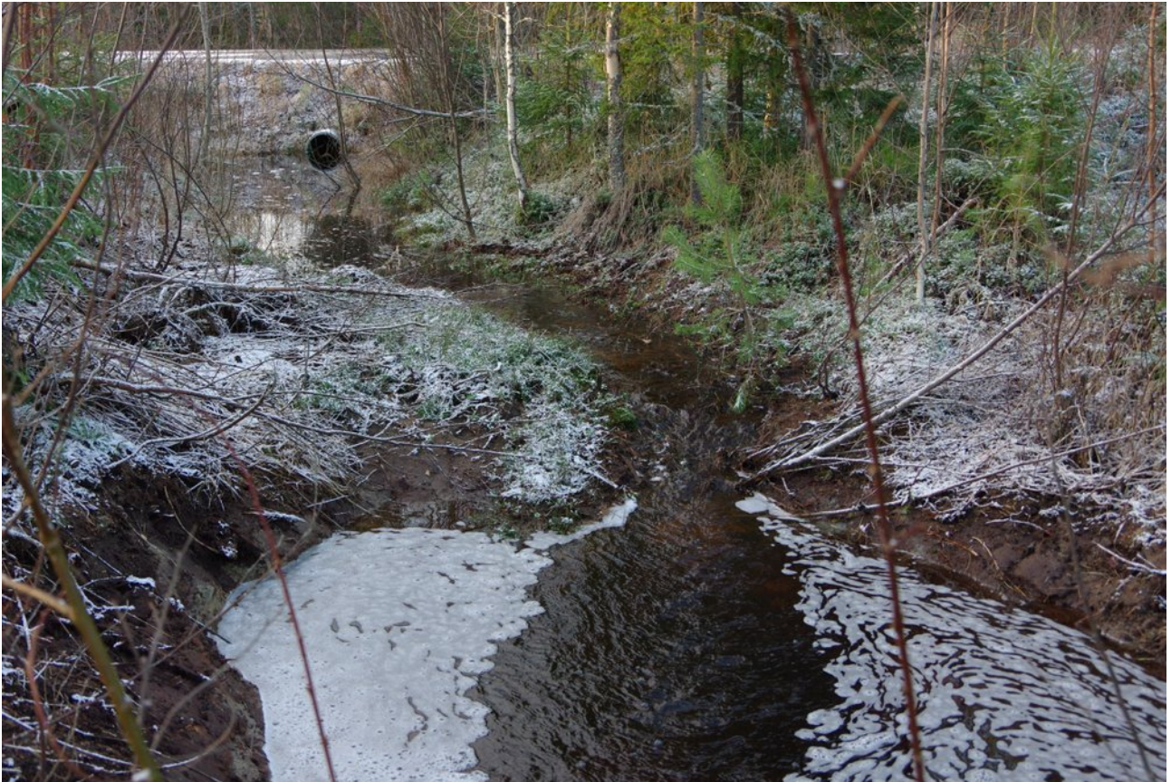
Figur 2: Tröskeln i åtgärd nr 1. Närbild på tröskeln.
