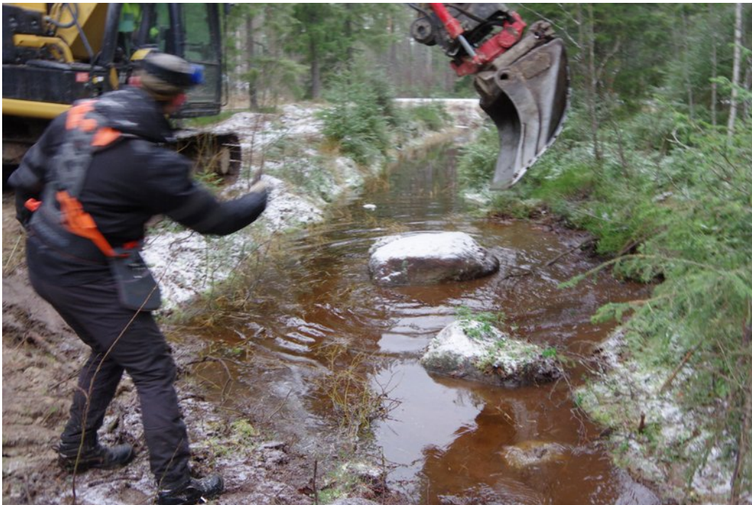
Figur 12: Den övre sedimentfällans grundområde förbereds.
