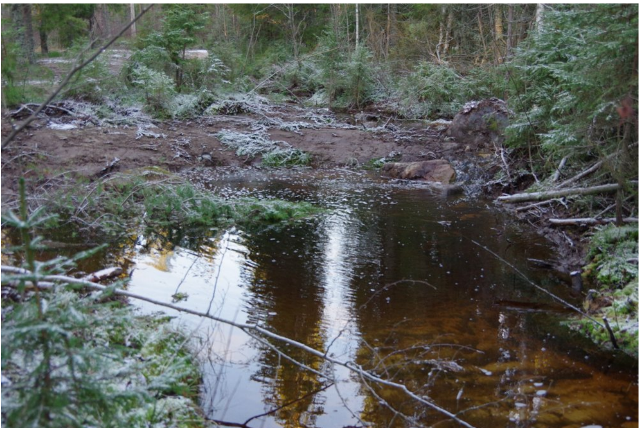
Figur 16: Nedre djuphålan och tröskeln två dagar efter åtgärd.
