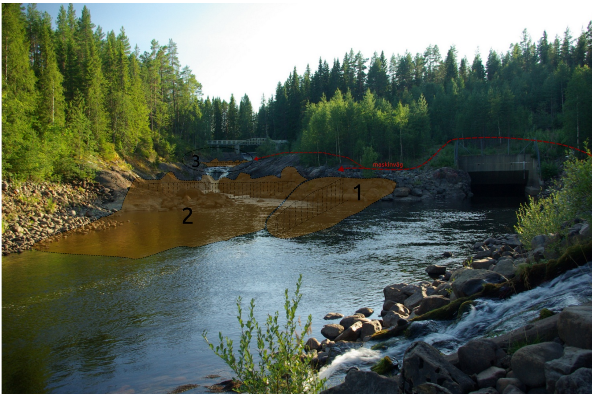
Figur 3: Schematiskt skiss av åtgärderna i Åselestupets nedre del. Nr 1: en vall med tät kärna för att kunna bygga nr 2; en tröskel för att minska fallhöjden i det nedre fall som uppstod genom muddringarna av Rickleån mellan Åselestupet och Orrselet. Uppströms nr 2, vid nr 3, placeras en mindre tröskel som främst byggs med flottledsrensat material som är upplagt på stranden i direkt anslutning till åtgärden. Se även kartan i Bilaga 1. Notera även Rismyrbäckens nuvarande utlopp mot Rickleån nere till höger i bild. Foto: Jan Åberg.
