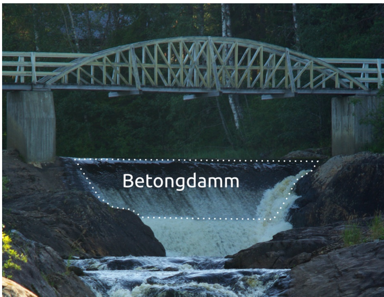
Figur 2: En betongdamm byggd samtidigt som Älglunds kraftverk omkring år 1985, skapar ett ca 4 meter högt fall i Åselestupet. Fallet blev ett definitivt hinder för fiskvandring. Foto: Jan Åberg.
