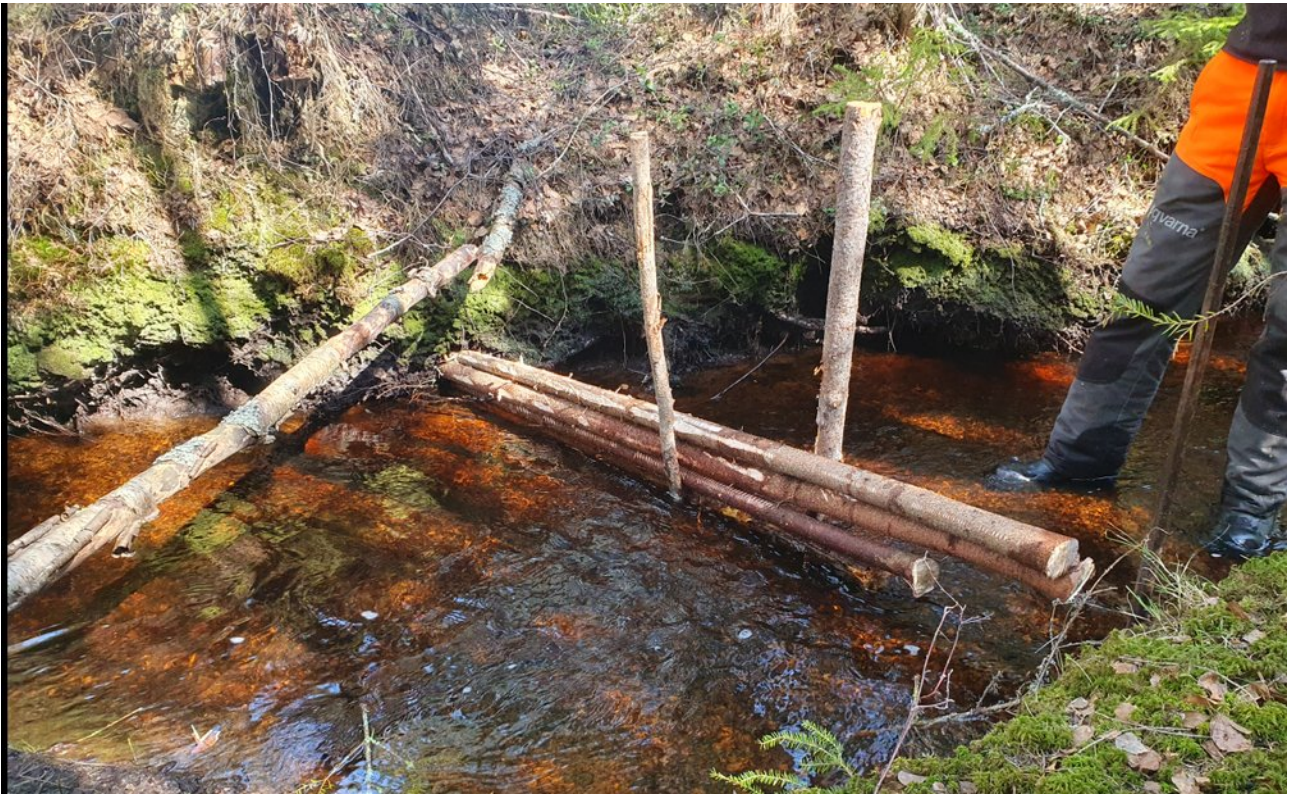
Meandringshjälpmedel under konstruktion
