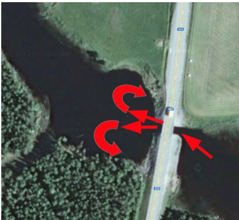
Figur 20: En vägbank med smal öppning har orsakat erosion mot väggkroppen. Det onaturligt kraftiga flödet genom bron har fördjupat vattendraget nedströms. De kraftiga motströmmarna har bidragit till ökad erosion mot bron och skred i närliggande skogs- och åkermark.
