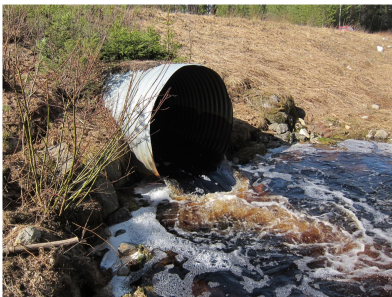
Figur 21: När denna vägtrumma anlades låg den en bit under bäckens nivå. Därefter har trumman "höjt sig" och skapat ett vandringshinder för fisk. Hur kunde trumman höja sig över bäckens nivå? Svar: En mycket stark och koncentrerad vattenström skapades eftersom trumman är smal i förhållande till flödet i bäcken. Den höga energin i flödet orsakade erosion som sänktes bäckens botten på nedströmssidan. Stora urgröpningar pga av denna typ av erosion riskerar också att skapa sättningar och skred i väggkroppen. Foto: Jan Åberg.
