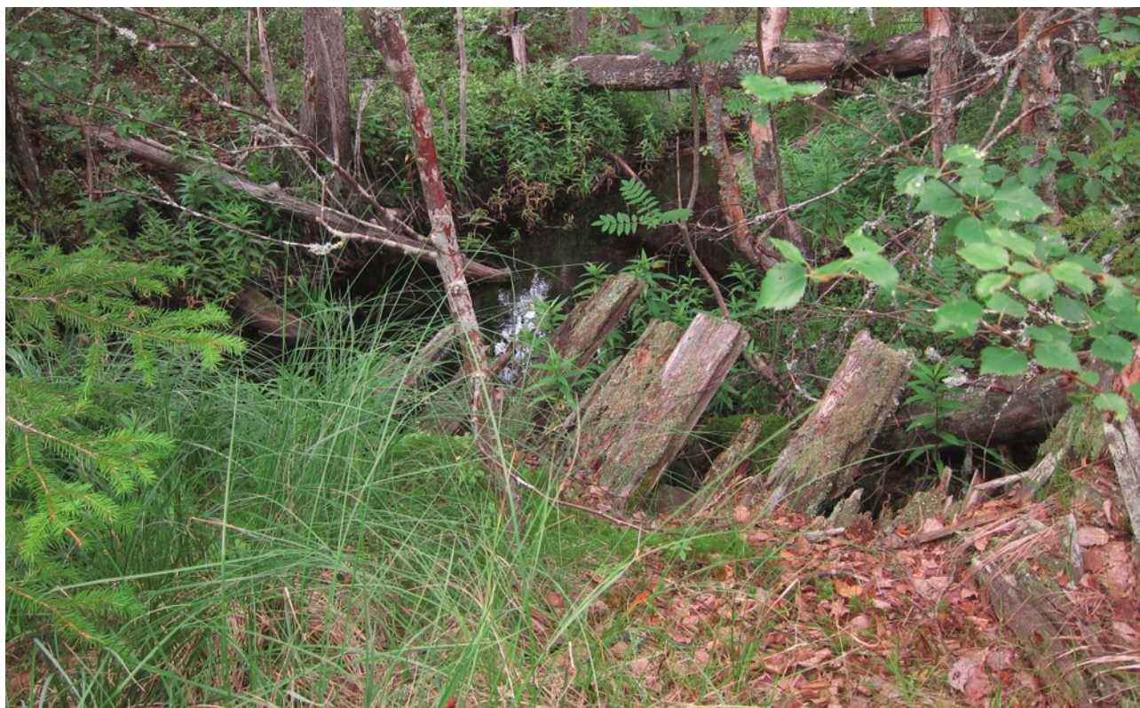
Figur 31: Rest av dämme i Vänforssjöns utlopp. Fram till början av 1970-talet hölls nivån några decimeter högre än idag på grund av denna konstruktion (Åberg 2012). På flygbilden från 1950-talet syns dock inte någon dämmande effekt. Foto: Jan Åberg år 2011.
