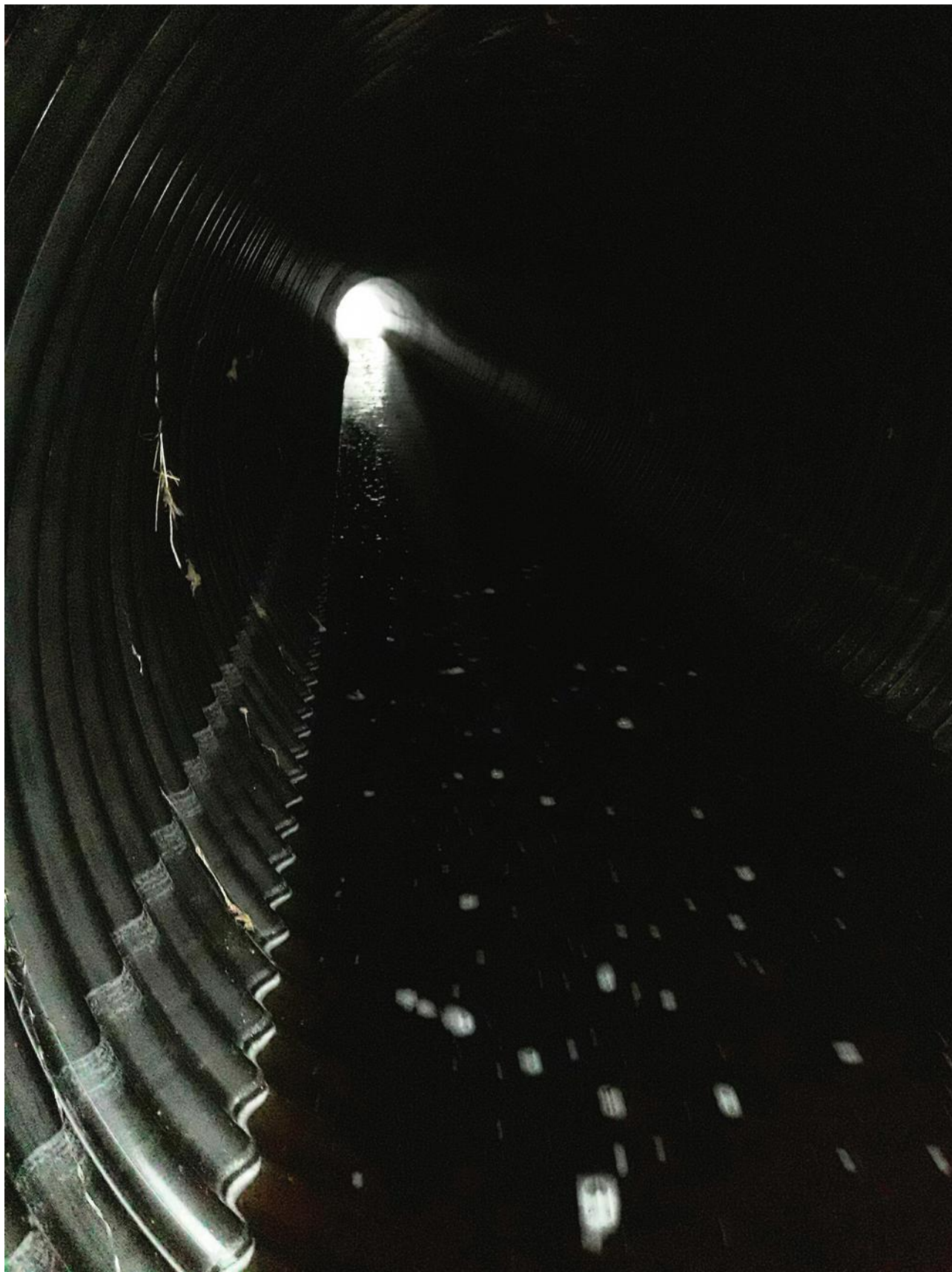
Trumman ligger så högt att fåran är betydligt smalare än den naturliga. Det saknas naturlig struktur av stenmaterial inuti, och trumman är ovanligt lång, ca 30 meter.
