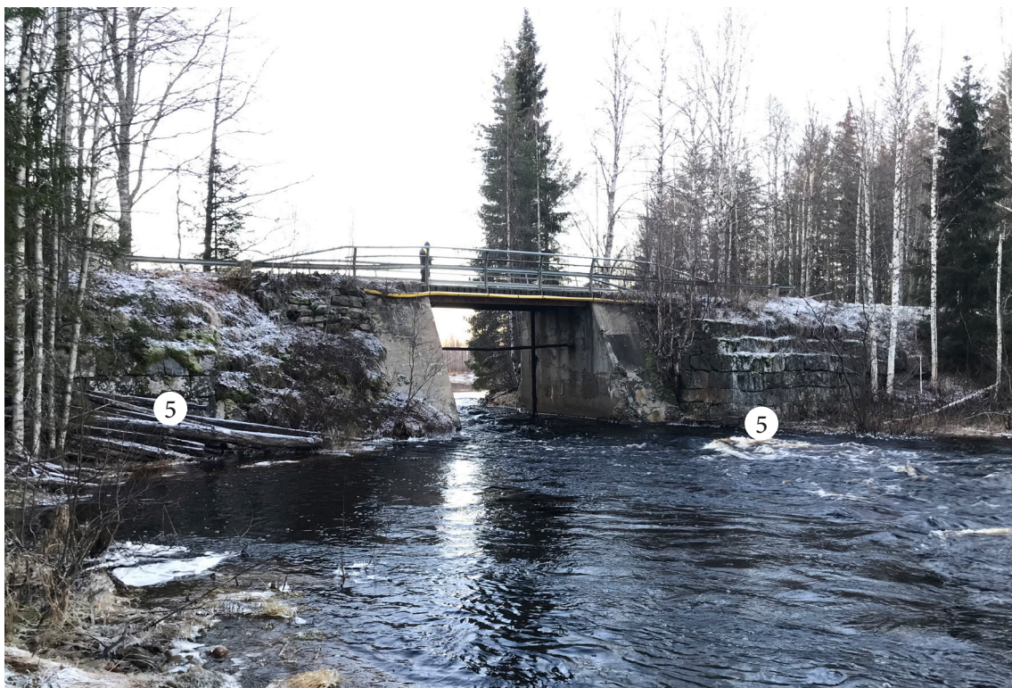
Risådammen nedströms och uppströms. 1) Dammkistor av helgjuten betong med sättfals. 2) Glacisinsättning. 3) Cementblock närmast dammkistan. 4) Vägbro med brobana av trä på järnbalk. 5) Rest av de gamla dammkistorna?
