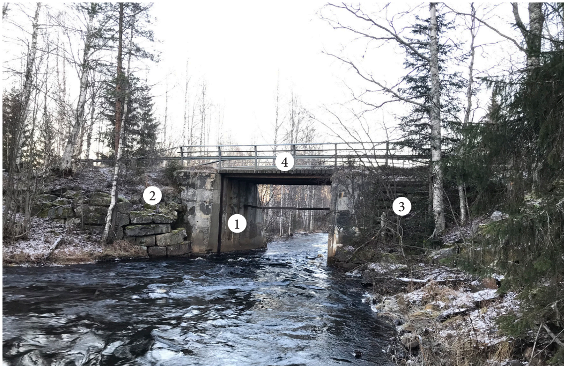
Risådammen nedströms och uppströms. 1) Dammkistor av helgjuten betong med sättfals. 2) Glacisinsättning. 3) Cementblock närmast dammkistan. 4) Vägbro med brobana av trä på järnbalk. 5) Rest av de gamla dammkistorna?
