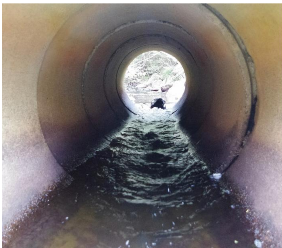
Vägtrumman strax uppströms den gamla kvarndammen i Avabäcken
