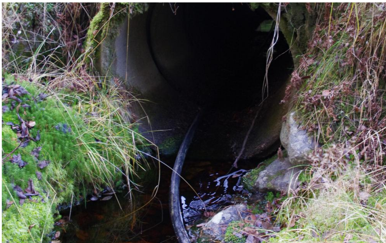
Högt liggande rundtrumma, strax uppströms Hermanbäckens utlopp mot Dalkarlsåns estuarie.
