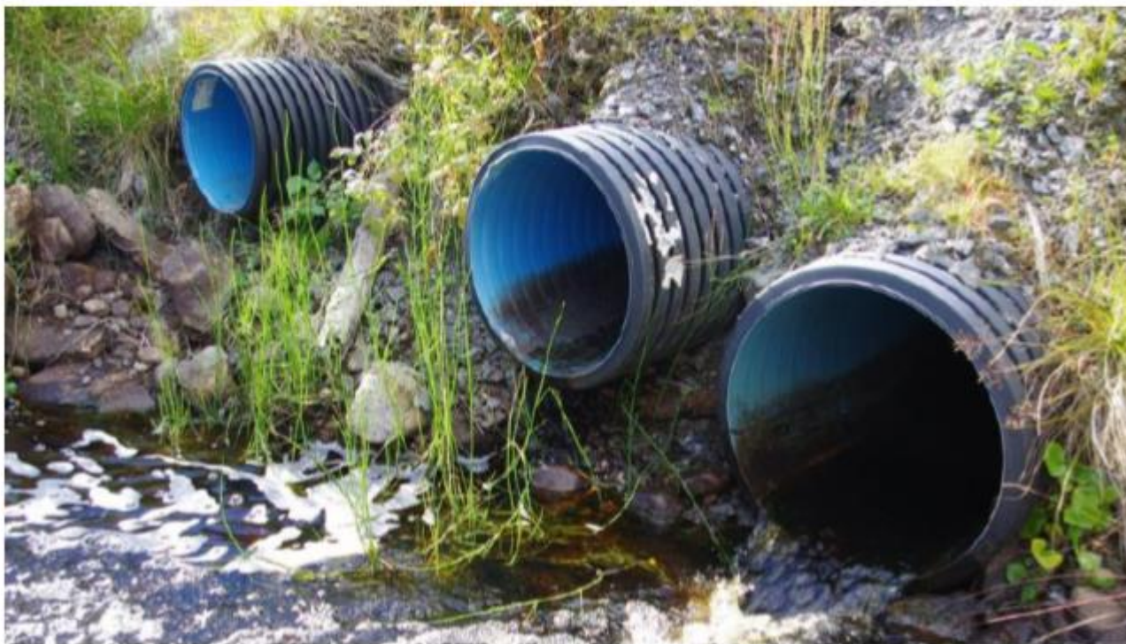
Bild: Tre vägtrummor som utgör vandringshinder i bäcken till Arvidviken (foto: Jan Åberg)
